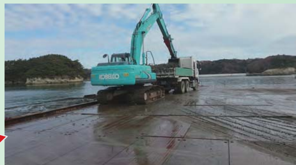
浚渫土をきれいにバックホウで均し、高さを計測して運ばれた土量を確認した後、10t ダンプに積み込みを行う。
