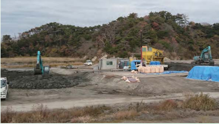
改良現場全体の写真
