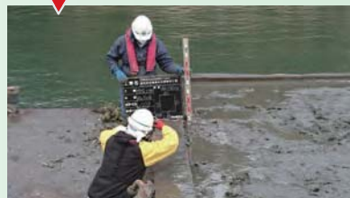
浚渫土をきれいにバックホウで均し、高さを計測して運ばれた土量を確認した後、10t ダンプに積み込みを行う。
