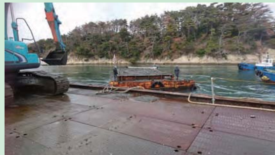
浚渫している場所から土運船で土砂が運ばれる。
