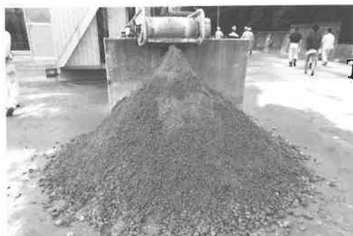
③改質直後のようす ④改質から2時間後にはダンブに積載可能
