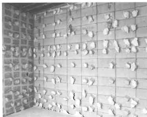
石膏ボード撤去後の接着工法の現場
